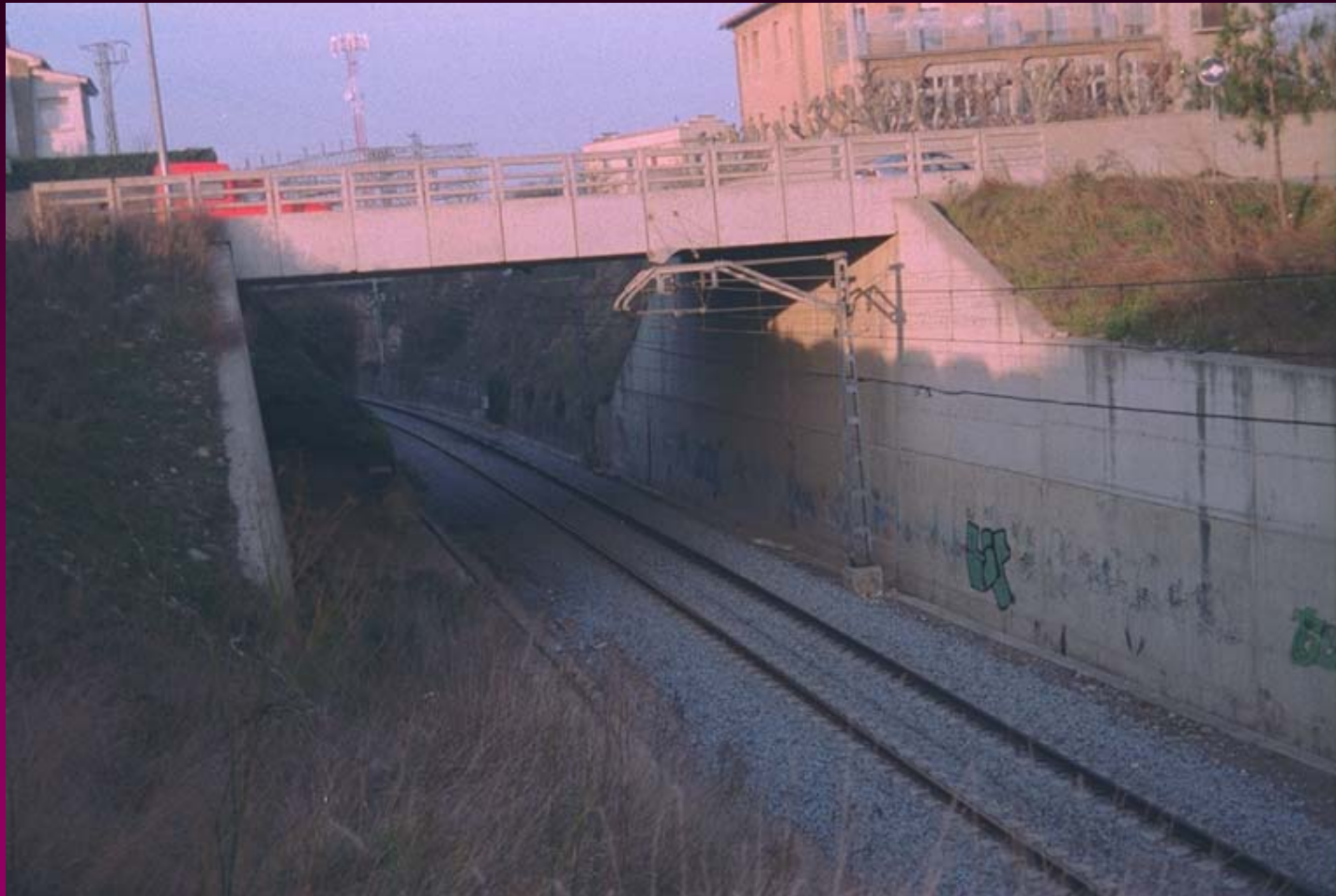
Estado actual del puente de la Sagrada Familia
