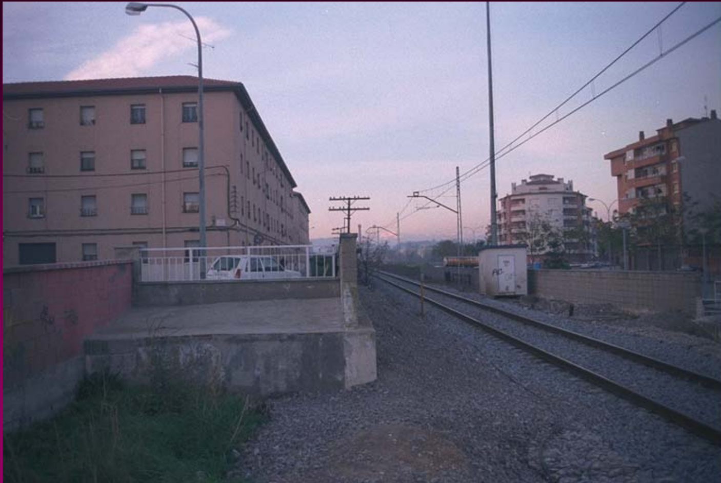
Estat actual dels Habitatges Montseny
