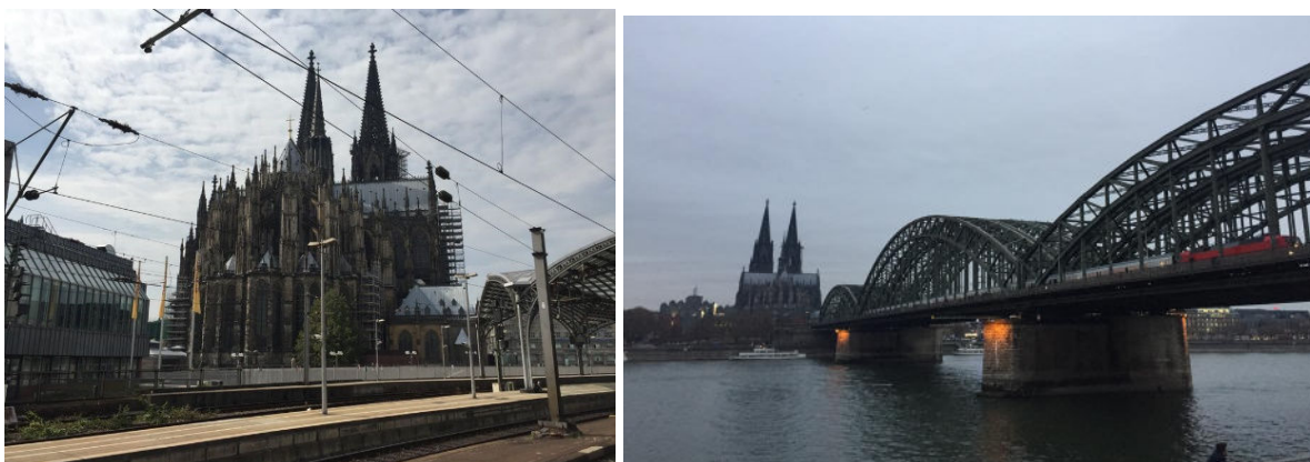
Exemple d'integració urbana del ferrocarril a la ciutat de Colònia. Font: Pròpia
