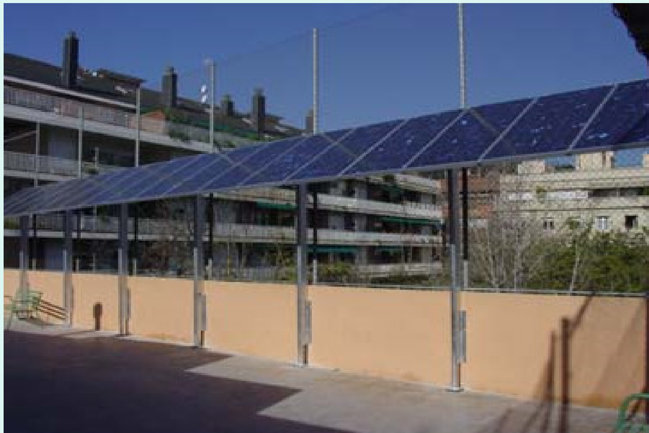
Instal·lació solar Fotovoltaica a l'IES Municipal Josep Serrat i Bonastre (xarxa d'escoles solars de Catalunya)
