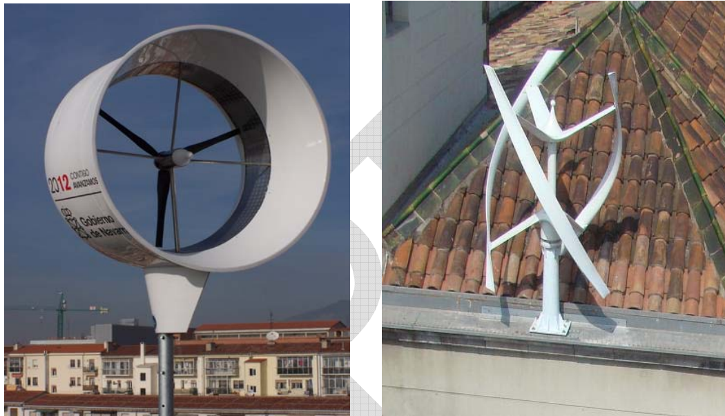
Figura 112. Aerogenerador d'eix horitzontal DonQi (1,75kW) i aerogenerador d'eix vertical d'Urban Green Energy (1 kW).
